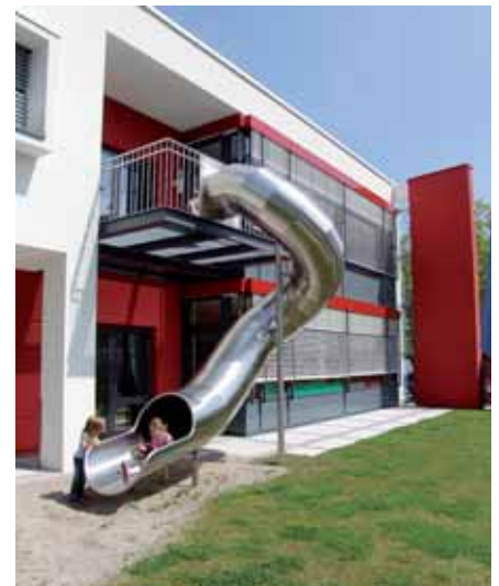
Die Edelstahlrutsche in München überwindet gar 4,80 Meter Höhendifferenz.
